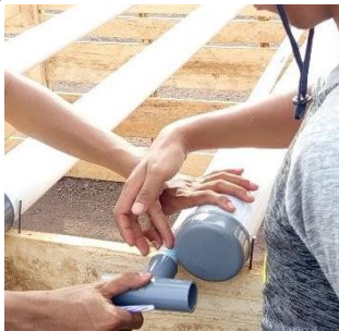
Gambar5. Pemasangan pipa akuaponik
