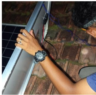
Gambar7. Pemasangan panel surya
